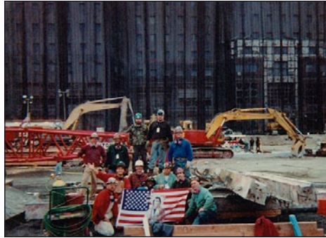
Stahlbauarbeiter am »Ground Zero«
