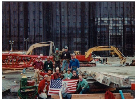
Stahlbauarbeiter am »Ground Zero«
